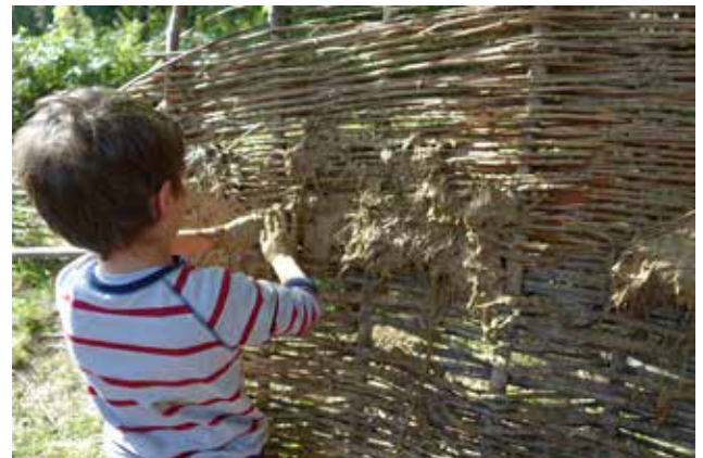
Verputzen einer Wand mit Lehm
